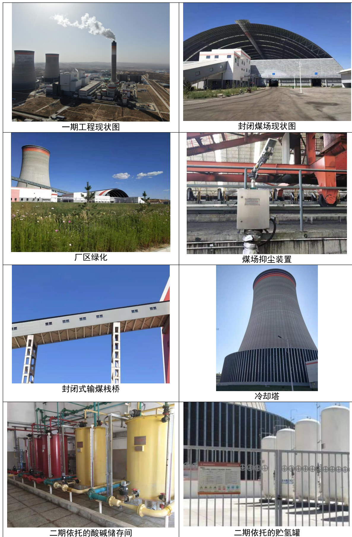
图3.1-2 厂区现状照片
