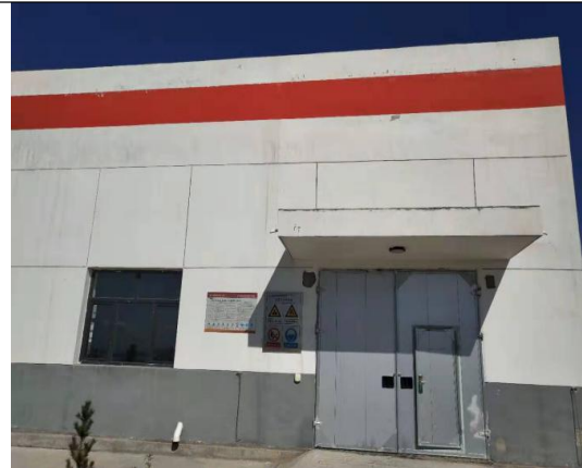
生活污水处理站
