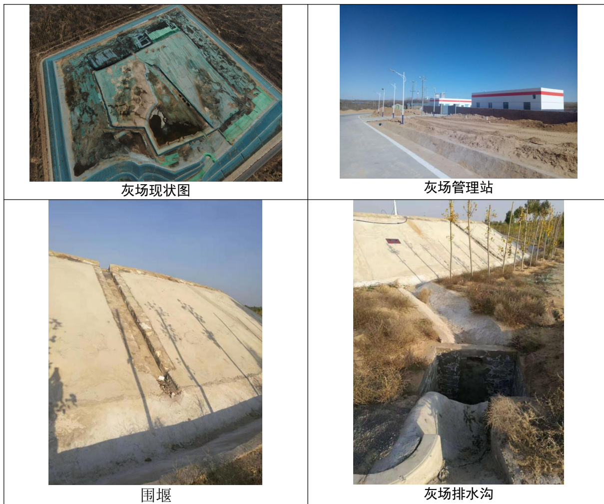
图 3.1-3 灰场现状照片
